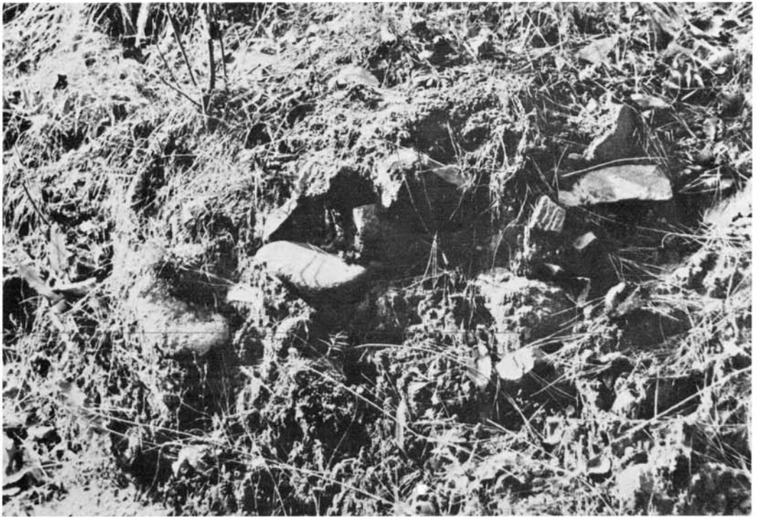
土石混築部分의 近景
